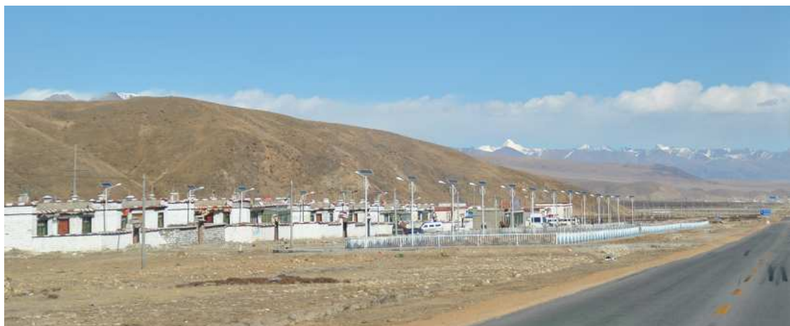
N-197a : NQ 山塊のネックを過ぎ、高度を下げる部分。
