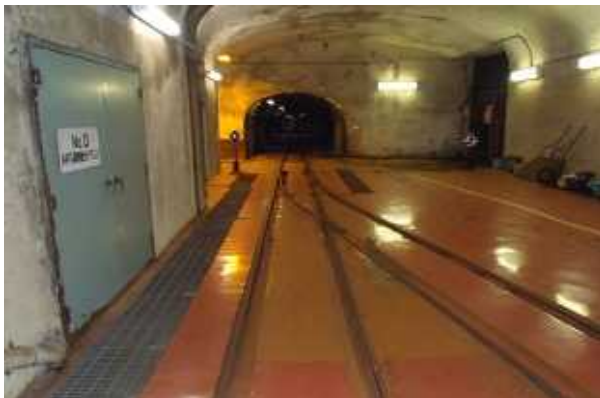
上部専用鉄道のトンネル。6.5 km 先の榎平まで続く。途中“高熱隧道”を通る。
