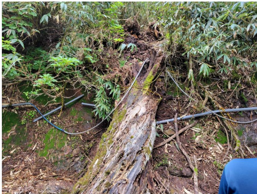
図5 水道管を切断し、別のホースでつないだ後の写真
